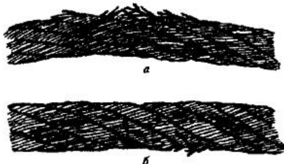
Рисунок 3. Обрывы проволок в зоне уравнильного блока:
